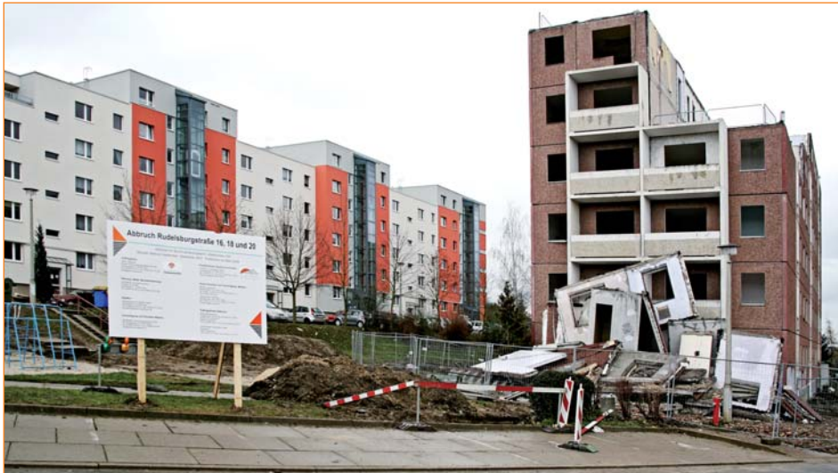
Dem Teilabriss in der Rudelsburgstraße folgen umfangreiche Sanierungs- und Modernisierungsmaßnahmen. (Foto: Vieweg)
